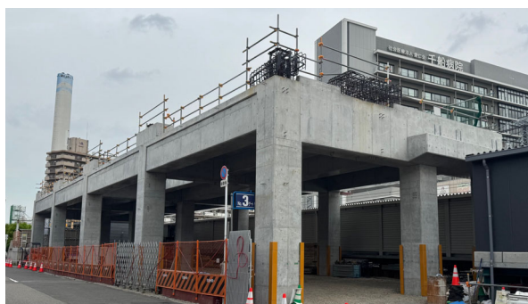
高架構造物の構築
