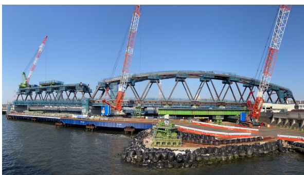
河川内の施工状況
