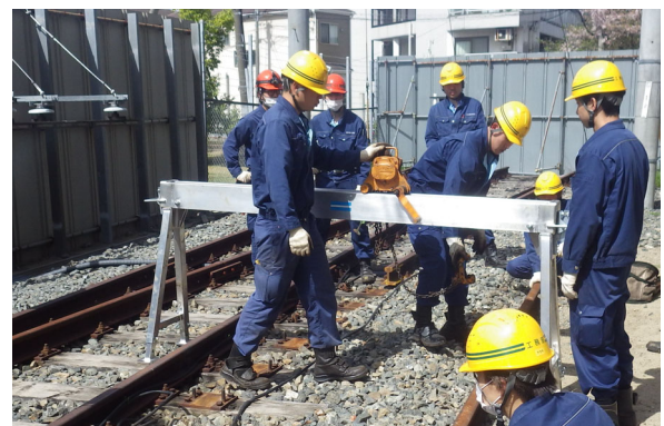
分岐レール更换合同訓練
