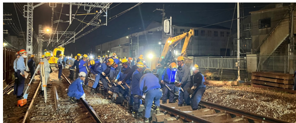
仮下り線切替工事状況
