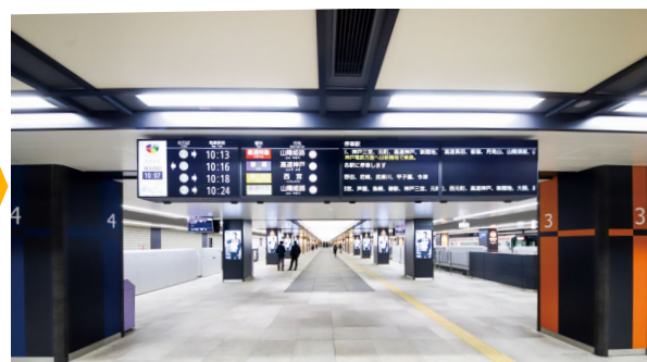
旧3番線を閉塞し、ホームを最大幅13.1mに拡幅
