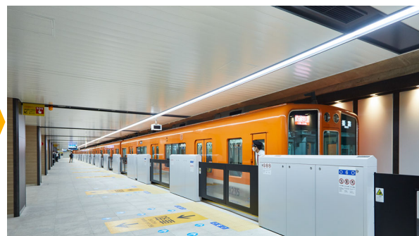
駅の北側を拡幅したスペースに新1番線を設置
