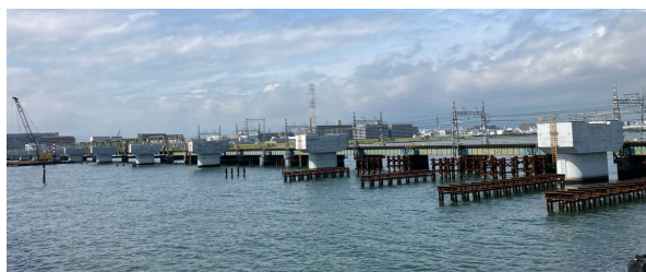
橋脚設置状況(淀川左岸)
