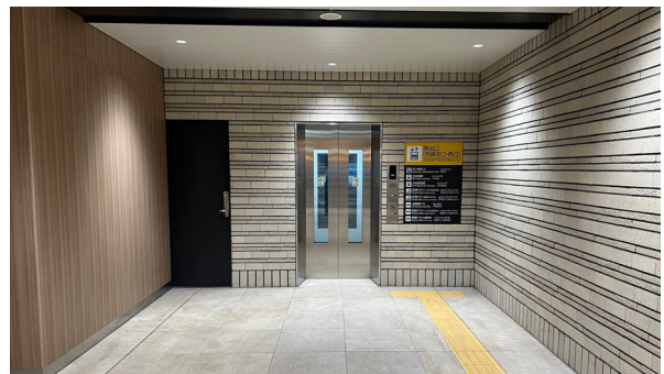
エレベーターの整備(西改札口)
