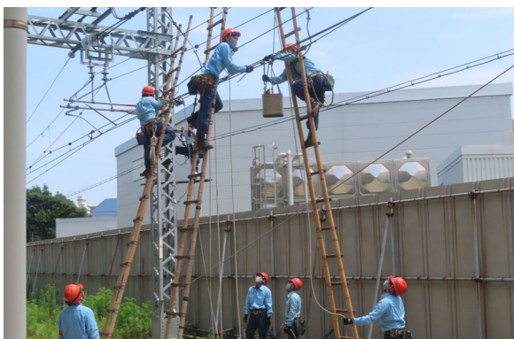
電車線断線復旧訓練
