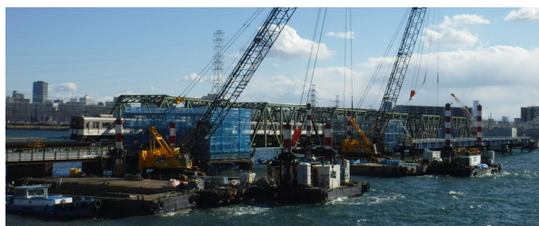
河川内の施工状況
