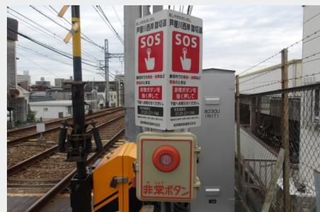
※1 移報システム：踏切支障報知装置(障害物検知装置、非常ボタンの総称)が動作したとき、特殊信号発光器の点灯と同時に、列車無線を介して運転士と運転指令に“●●踏切、異常発生！”という自動音声により通報する当社独自のシステムです。
