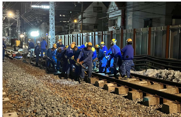
仮上り線(2回目)切替工事状況
