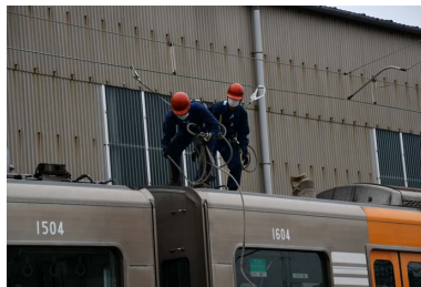
電車線断線復旧
