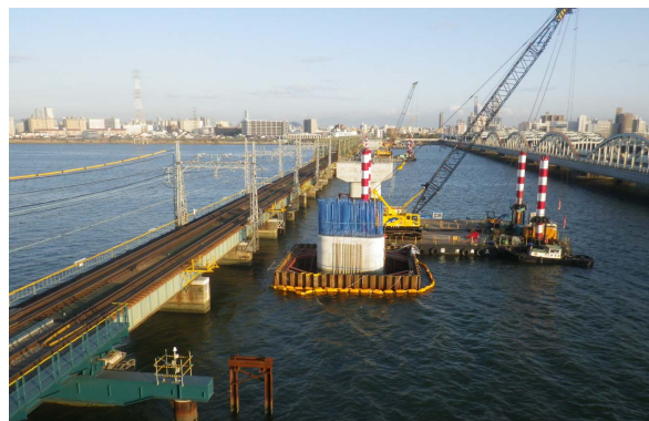
橋脚設置状況(淀川西方から)
