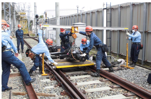
分岐転てつ機交換訓練
