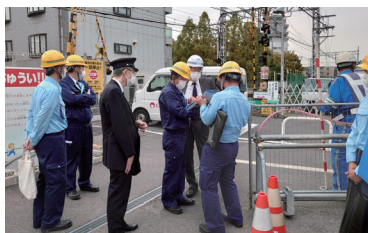
現場巡視(福駅仮線現場)
