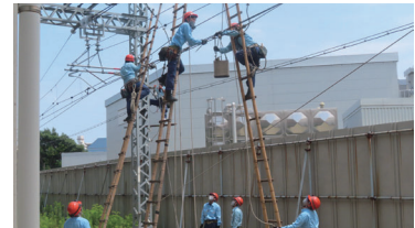
電車線断線復旧訓練
