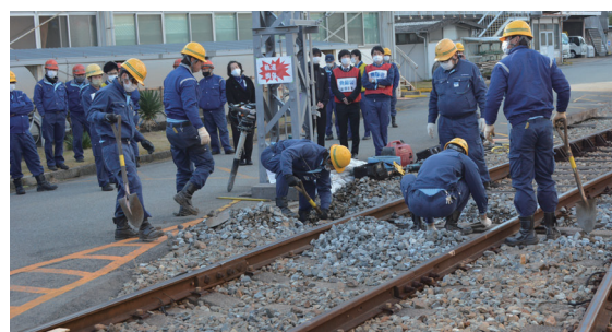
軌道復旧訓練
