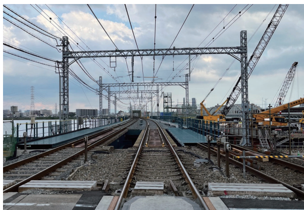
仮下り線切替後
