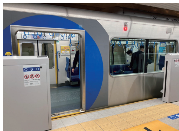
ホームドアの緊急開扉
