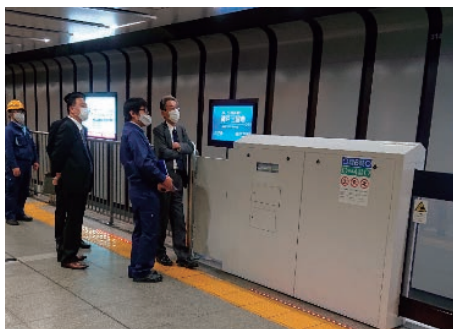
現場巡視(可動式ホーム柵)
