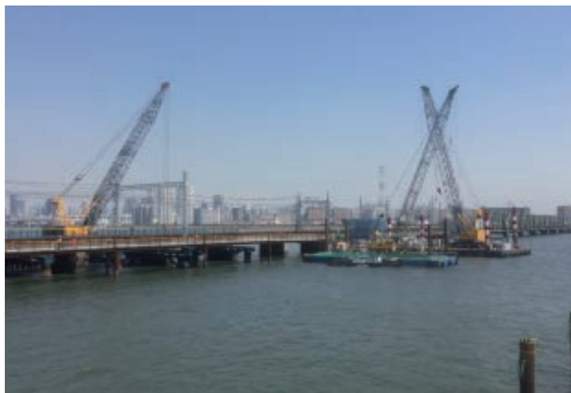
現在の工事の様子
