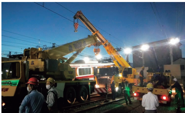
復旧作業の様子(事故当日)
