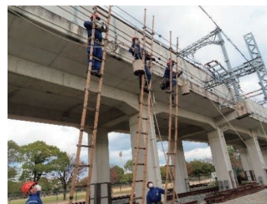
断線復旧訓練
