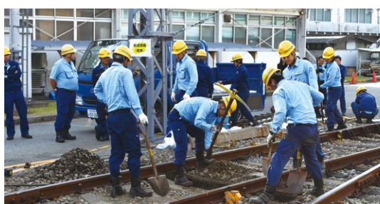
軌道復旧訓練（工務部）
