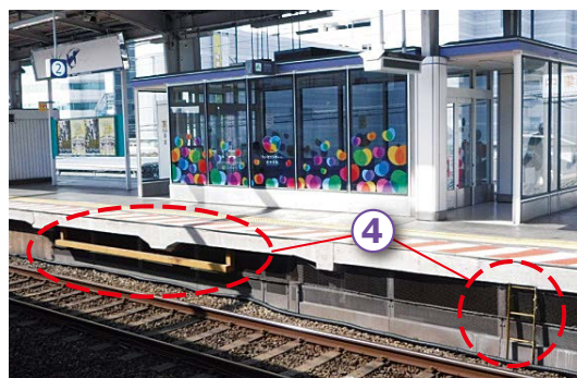
待避用ホームステップ （左側破線内がバー形式、右側破線内が梯子形式）
