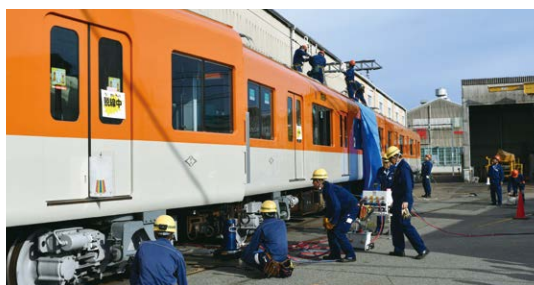
電車線断線・列車脱線復旧訓練（電気部・車両部）
