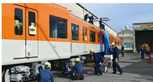
電車線断線・列車脱線復旧訓練（電気部・車両部）
