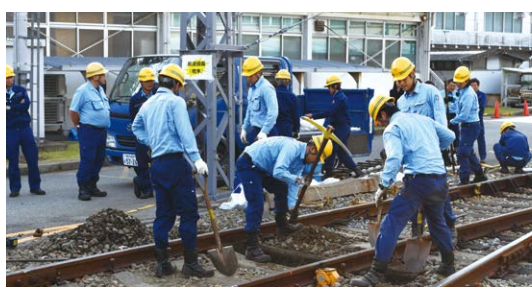
軌道復旧訓練（工務部）
