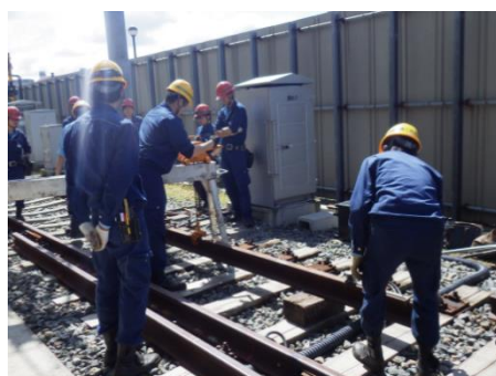
分岐器レール交換訓練
