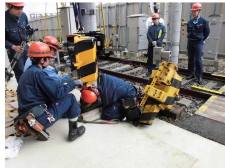
踏切保安装置復旧訓練
