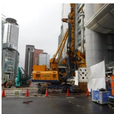
障害物撤去工事状況
