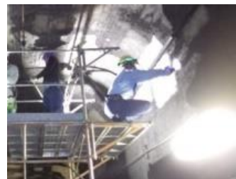
打音検査状況
