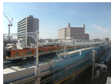
高架橋工事現場（青木駅部）
