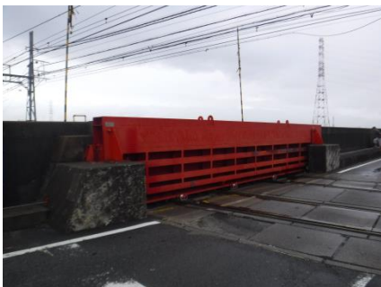
防潮鉄扉閉鎖状況
