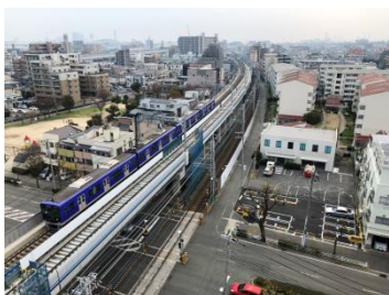
高架橋工事現場（青木駅・深江駅間）
