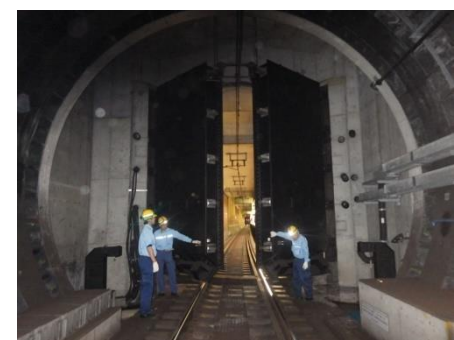
地下駅水防訓練
