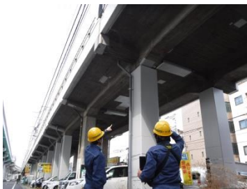
地上からの目視検査
