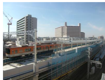
高架橋工事現場（青木駅部）
