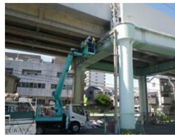
近傍での詳細目視検査
