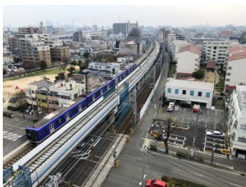
高架橋工事現場（青木駅・深江駅間）
