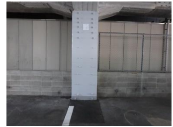
一面せん断補強工法
