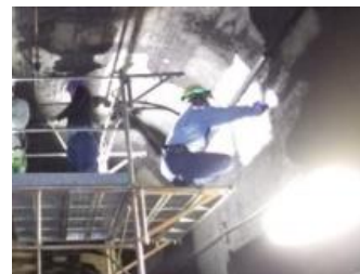
打音検査状況
