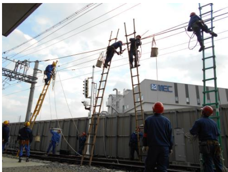
断線復旧訓練
