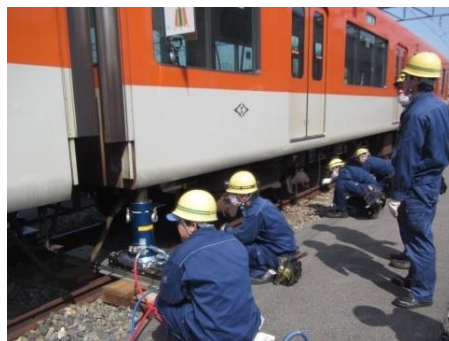
脱線復旧訓練
