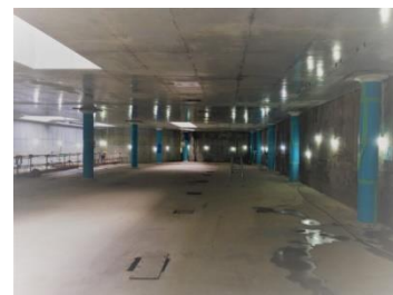
躯体構築状況
