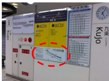
避難経路図設置状況
