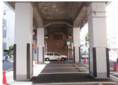
鋼板巻き立て補強工法
