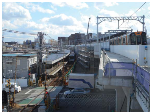
高架橋工事現場（鳴尾駅付近）
