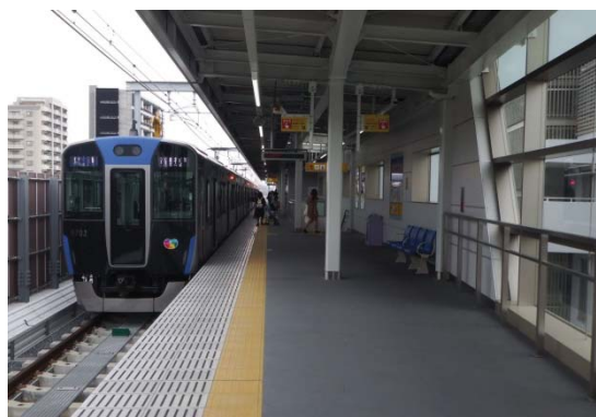
高架化した深江駅下りホーム
