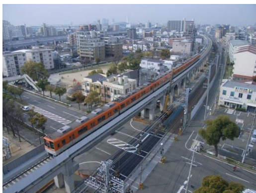
高架橋工事現場（青木駅・深江駅間）
