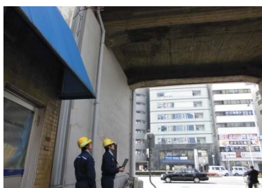
橋梁下面からの目視検査
