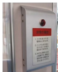
非常通報装置
