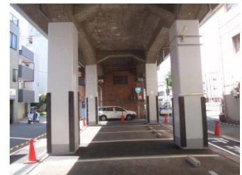
鋼板巻き立て補強工法
