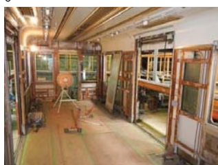
リニューアル工事の状況
