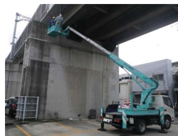
近傍での詳細目視検査
