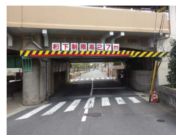
陸橋防護工(桁)
