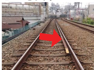
脱線防止ガード 設置現場
