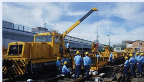
重トロリー脱線復旧訓練
