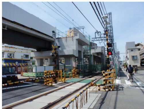
高架橋工事現場（鳴尾駅・武庫川駅間）
