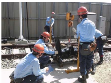
信号設備障害復旧訓練
