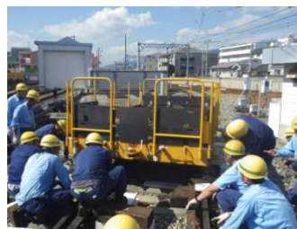
重トロリー脱線復旧訓練
