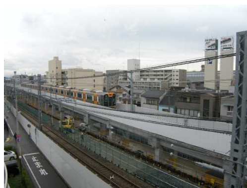
高架橋工事現場（鳴尾駅・武庫川駅間）
