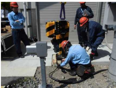
信号設備障害復旧訓練
