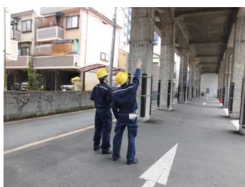
橋梁下面からの目視検査
