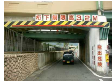
陸橋防護工(桁)
