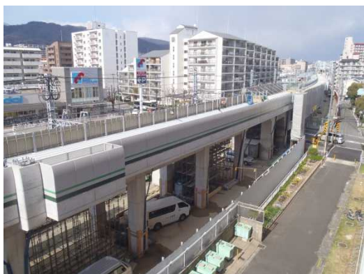
高架橋工事現場（魚崎駅・青木駅間）
