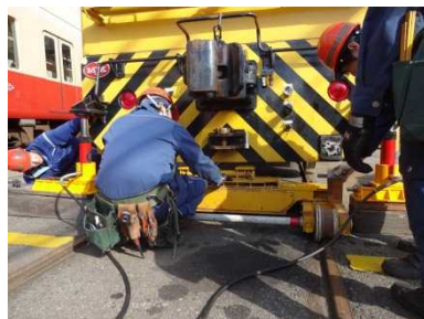
重トロリー運転取扱い訓練
