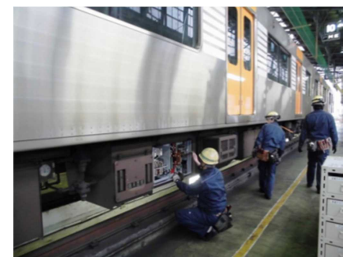
状態・機能検査(月検査)
