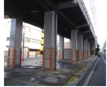
鋼板巻き立て補強工法
