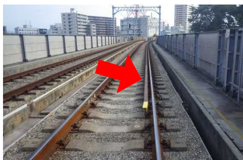
脱線防止ガード 設置現場
