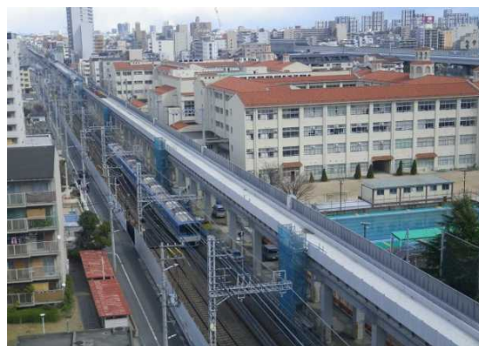
高架橋工事現場（青木駅・深江駅間）
