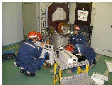
変電設備障害復旧訓練
