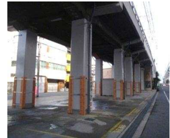
鋼板巻き立て補強工法
