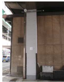
一面せん断補強工法
