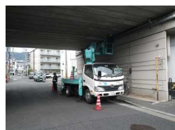
近傍での詳細目視検査
