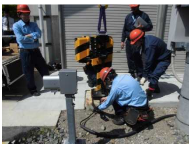
信号設備障害復旧訓練
