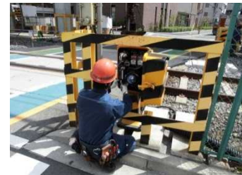
踏切保安装置の定期検査
