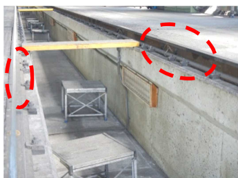
ひずみゲージ設置箇所
