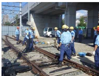
分岐器トングレール更換訓練
