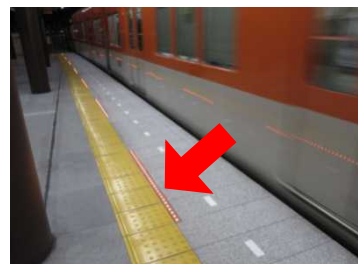
ホーム床面発光式列車接近表示器
