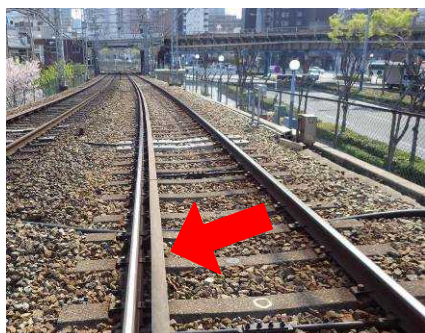
脱線防止ガード 設置現場
