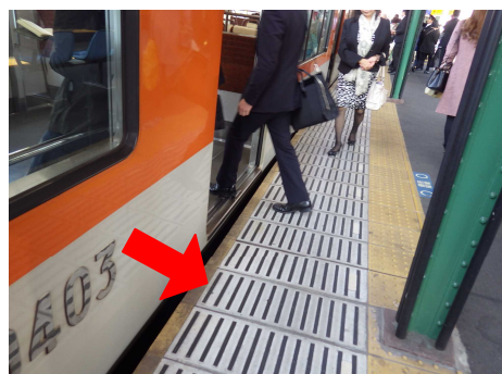
楡状ゴム 設置状況
