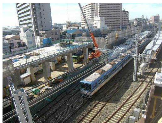
高架橋工事現場（青木駅部）
