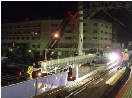
上り線 橋梁架設
