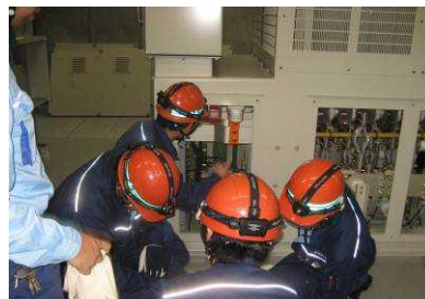
変電設備障害復旧訓練
