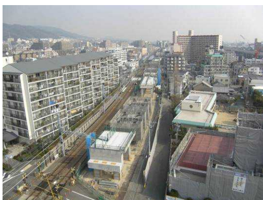
高架橋工事現場（魚崎駅・青木駅間）
