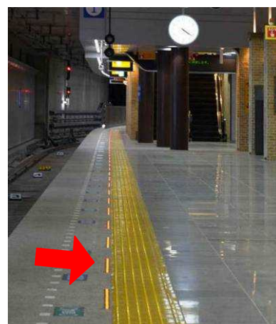
ホーム床面発光式列車接近表示器
