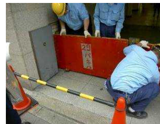
地下駅水防訓練
