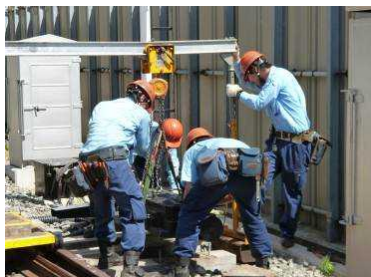
信号設備障害復旧訓練
