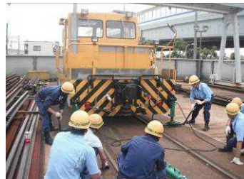
重トロリー脱線復旧訓練
