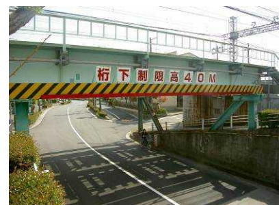
橋桁防護工(桁)
