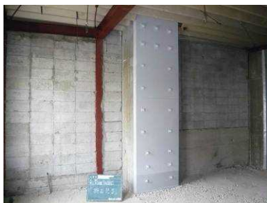
一面せん断補強工法
