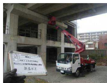
近傍での詳細目視検査
