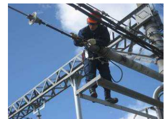
自動張力調整装置点検
