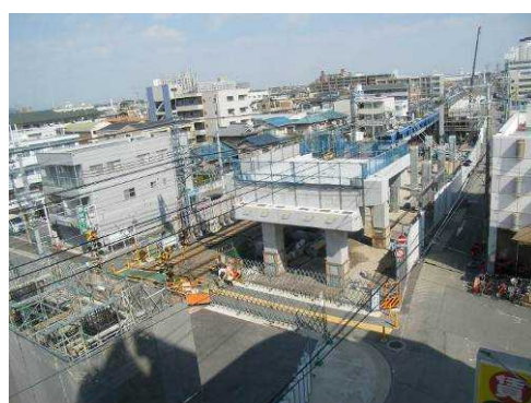
高架橋工事現場（鳴尾駅東方）
