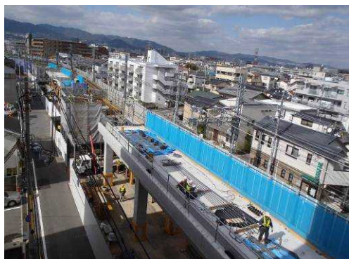
高架橋工事現場（甲子園駅・鳴尾駅間）
