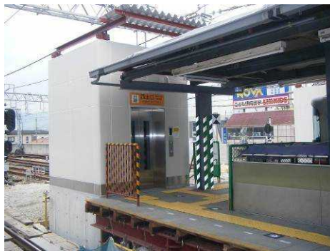
下りホーム エレベーター設置
