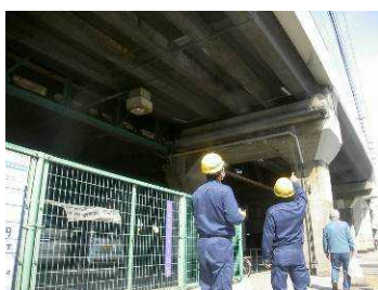
橋梁下面からの目視検査
