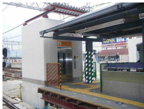
下りホーム エレベーター設置
