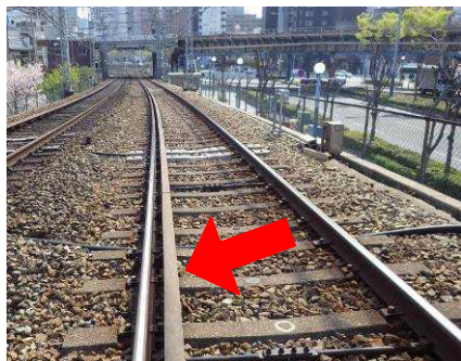
脱線防止ガード 設置現場
