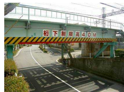
橋桁防護工(桁)
