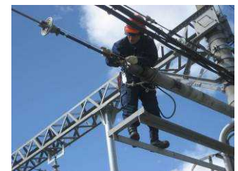
自動張力調整装置点検
