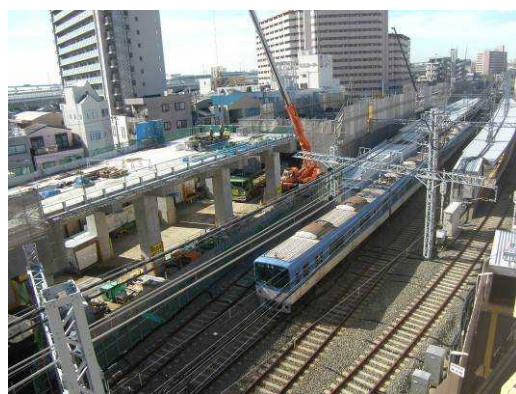
高架橋工事現場（青木駅部）
