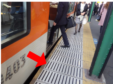
楡状ゴム 設置状況
