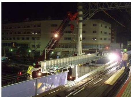
上り線 橋梁架設
