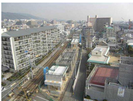
高架橋工事現場（魚崎駅・青木駅間）
