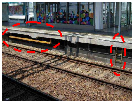
待避用ホームステップ (左側破線内がバー形式、右側破線内が梯子形式)
