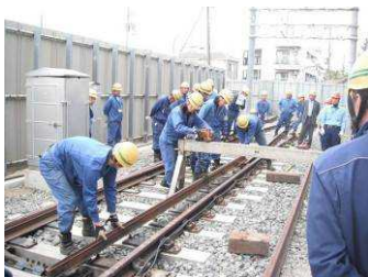
分岐器トングレール更換訓練
