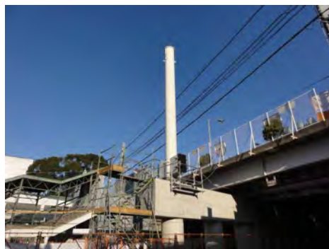
大屋根部 上家柱設置
