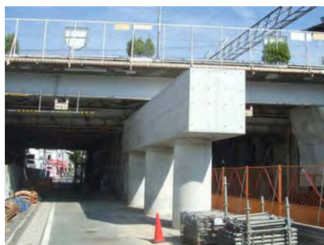
下り線側 橋脚構築
