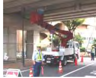
近傍での詳細目視検査
