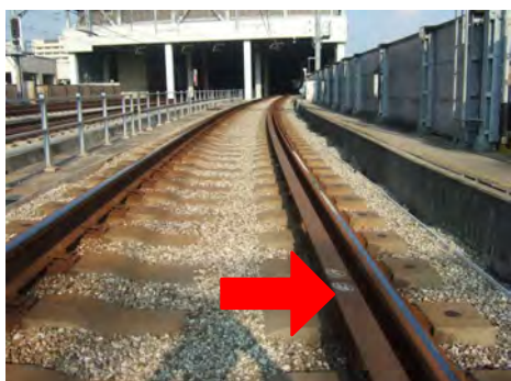
脱線防止ガード 設置現場
