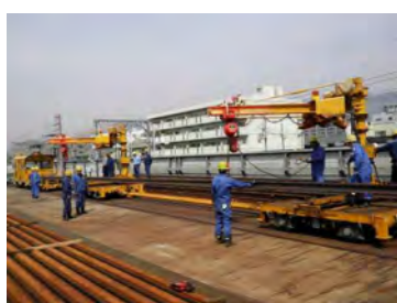
レール運搬台車取扱い講習
