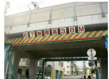
橋桁防護工(桁)
