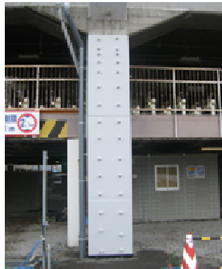
一面せん断補強工法
