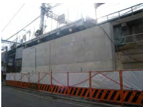
北東側 擁壁補強
