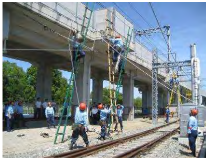
電車線断線復旧訓練
