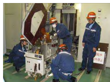
直流高速度遮断器特性試験
