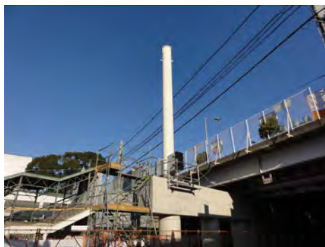
大屋根部 上家柱設置
