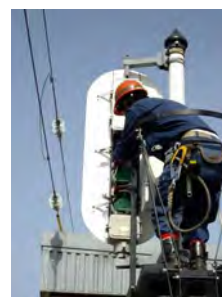
信号機の定期検査
