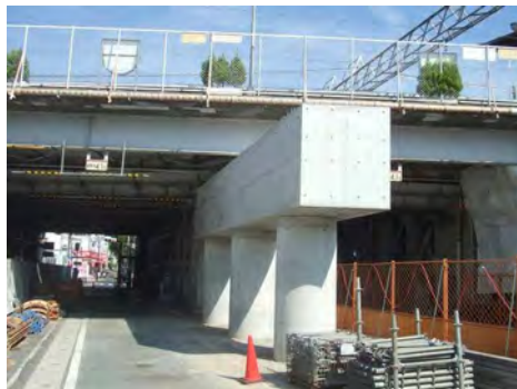
下り線側 橋脚構築
