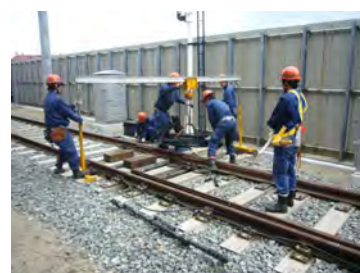
信号設備障害復旧訓練
