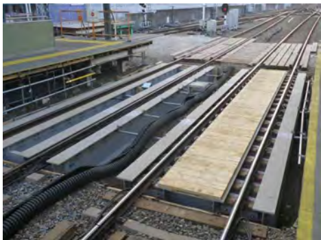
西改札口新設交差道路部 工事桁架設
