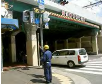
橋梁下面からの目視検査
