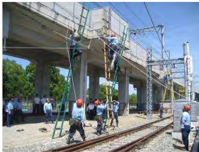
電車線断線復旧訓練
