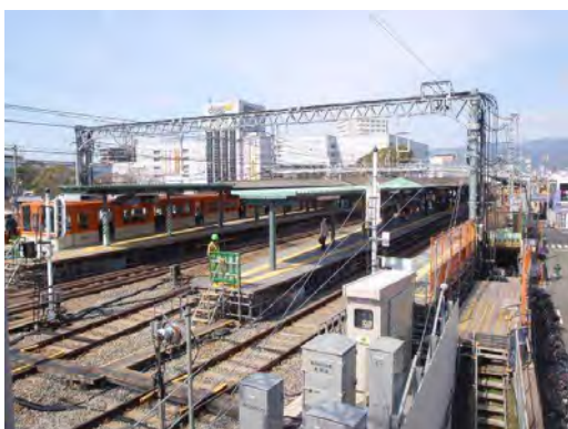
甲子園駅東方 仮ホーム化
