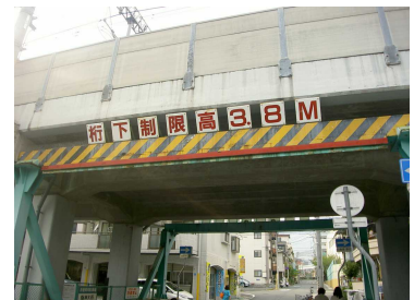
橋桁防護工(桁)
