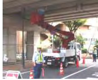
近傍での詳細目視検査
