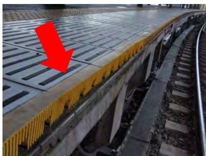
楕状ゴム 設置状況
