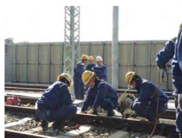
レール折損事故時の応急復旧訓練
