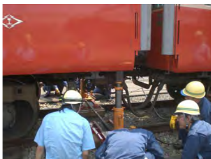
脱線復旧訓練
