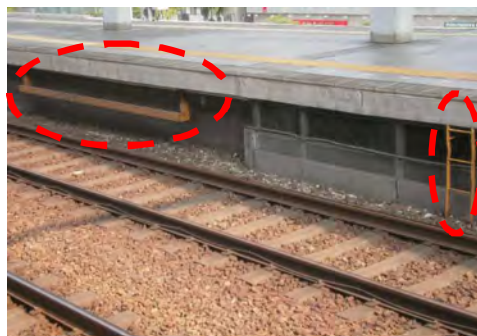
待避用ホームステップ (左側破線内がバー形式、右側破線内が梯子形式)
