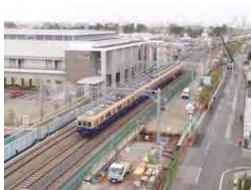
高架橋工事現場（西宮市内）
