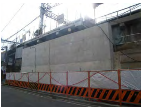
北東側 擁壁補強
