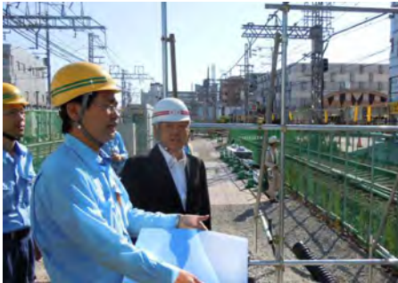
鳴尾連立工事視察（社長）
