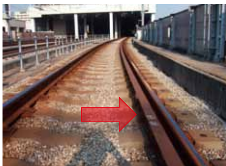
脱線防止ガード 設置現場
