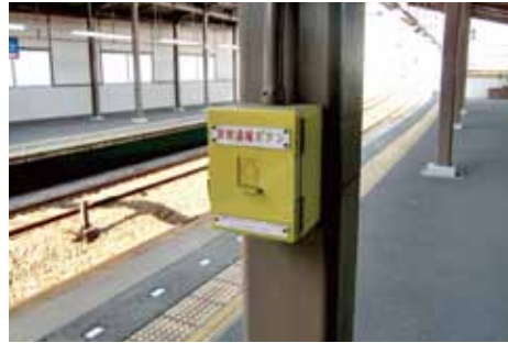
非常通報ボタン
