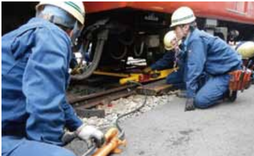
脱線復旧訓練
