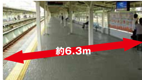
プラットホーム拡幅後
