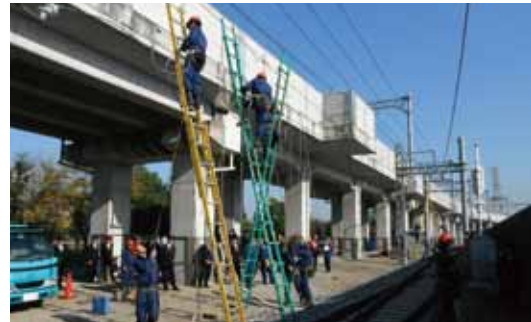
電車線断線復旧訓練
