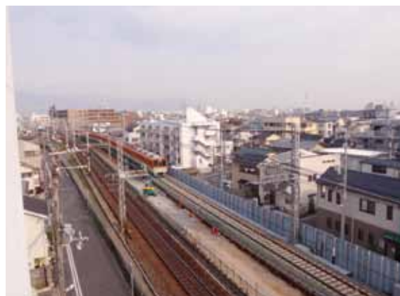
仮線工事現場(西宮市内)
