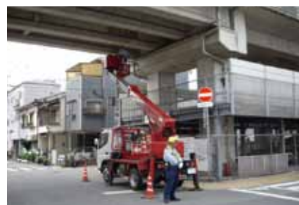
近傍での詳細目視検査
