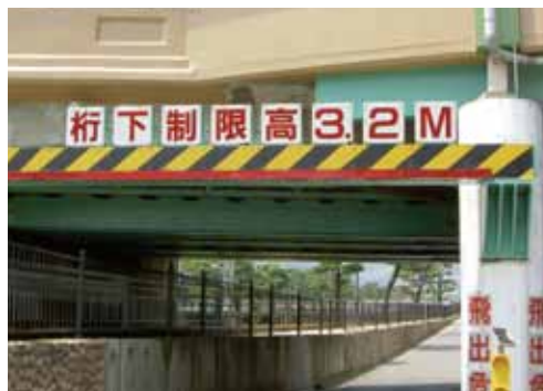
橋桁防護工(桁)
