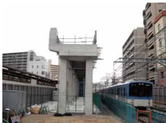
高架橋工事現場(神戸市内)
