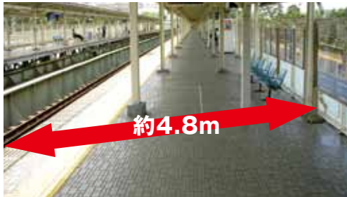
プラットホーム拡幅前
