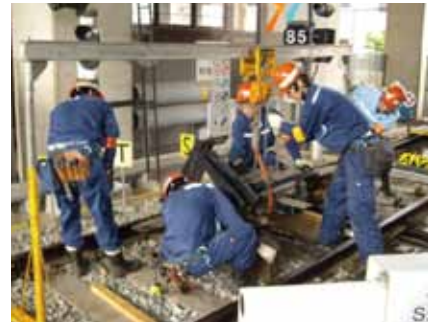
信号設備障害復旧訓練
