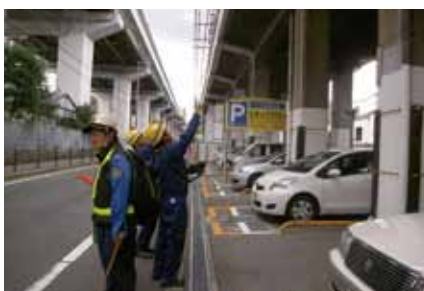
橋梁下面からの目視検査
