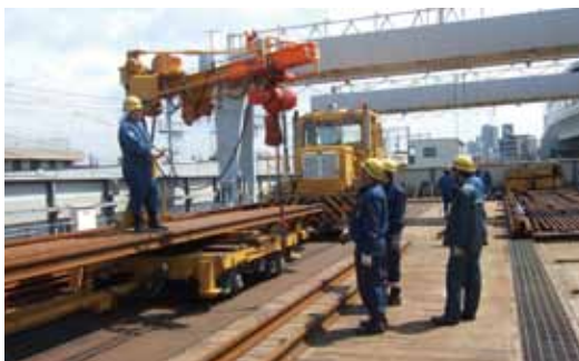
レール運搬台車取扱い講習
