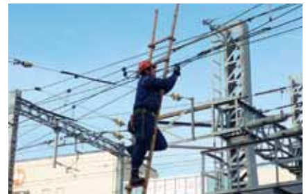
トロリ線摩耗測定
