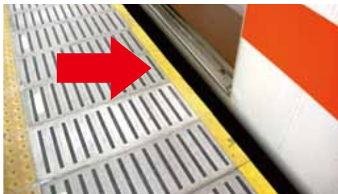
櫛状ゴム 設置現場
