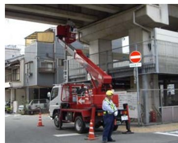
近傍での詳細目視検査
