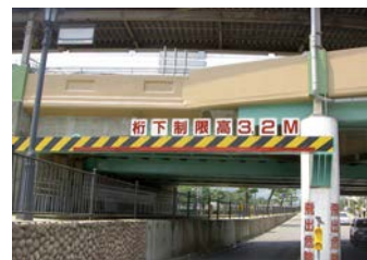
橋桁防護工(桁)
