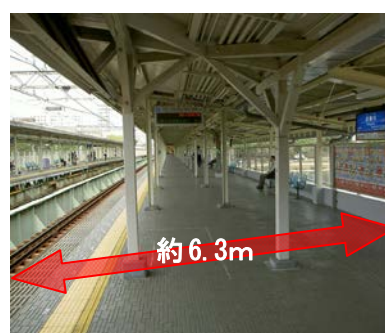
プラットホーム拡幅後
