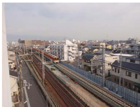
仮線工事現場(西宮市内)
