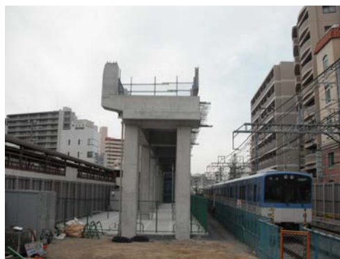
高架橋工事現場(神戸市内)
