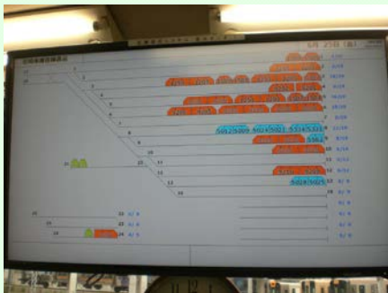
車両在線表示システムモニタ（尼崎車庫）
