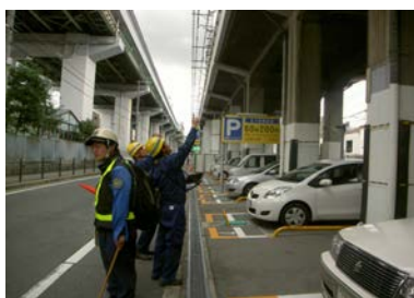
橋梁下面からの目視検査
