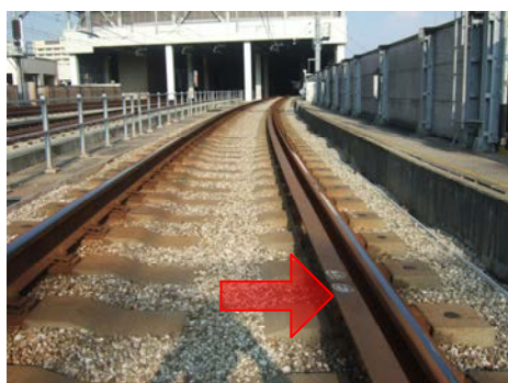
脱線防止ガード 設置現場
