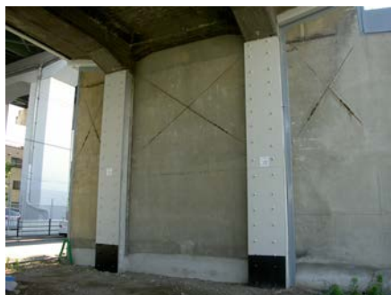
一面せん断補強工法
