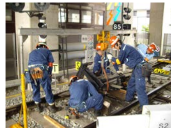
信号設備障害復旧訓練
