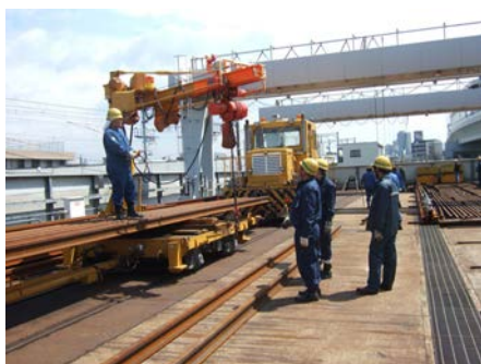
レール運搬台車取扱い講習
