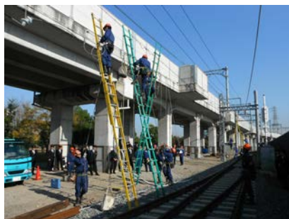
電車線断線復旧訓練
