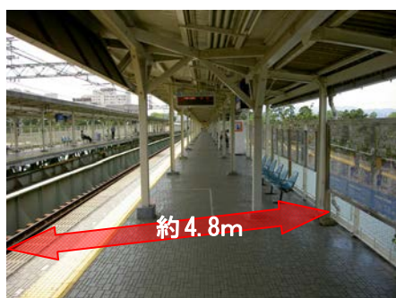
プラットホーム拡幅前
