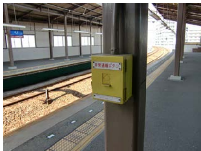
非常通報ボタン
