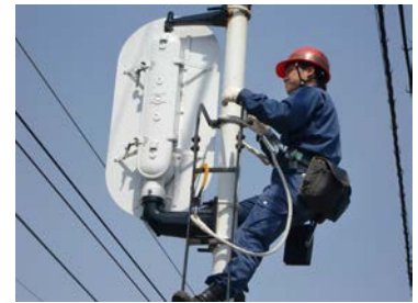
信号機の定期検査
