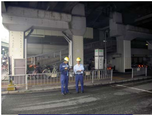
【橋梁下面からの目視検査】
