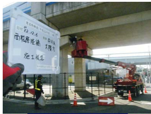
【近傍での詳細目視検査】
