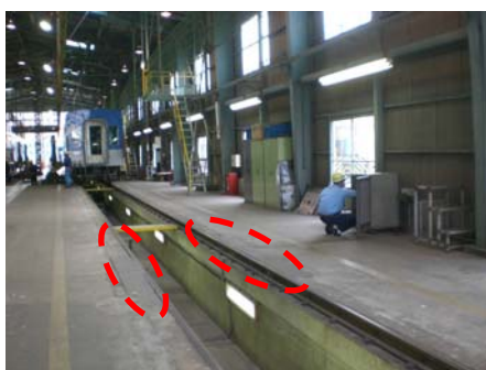
【破線内がひずみゲージ設置箇所】
