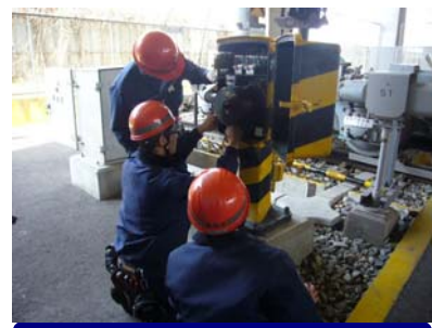
【信号設備障害復旧訓練】
