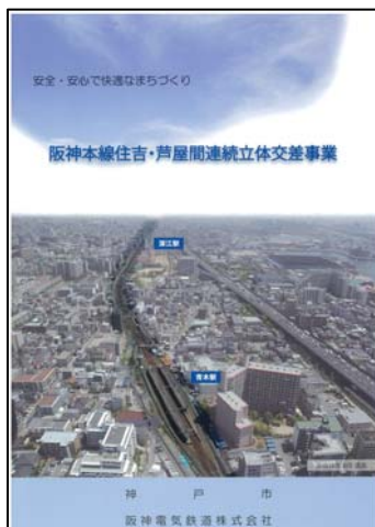
【本線住吉・芦屋間高架化(神戸市内)】
