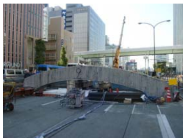
【既設構造物撤去状況】
