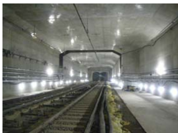
【新設構造物構築状況】
