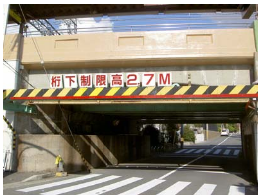
【橋桁防護工(桁)】
