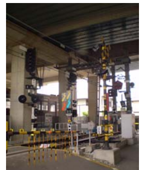
【教育訓練用の模擬踏切道諸施設】
