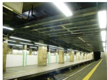
【コンコース中床版設置状況】
