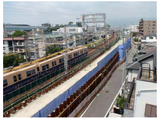
【仮線工事現場(西宮市内)】
