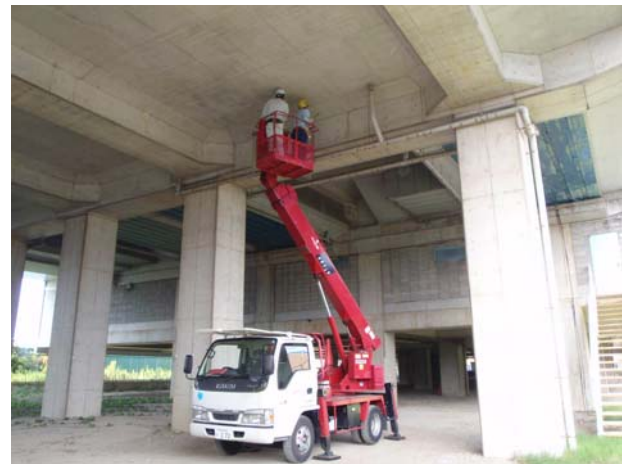
【近傍での詳細目視検査】
