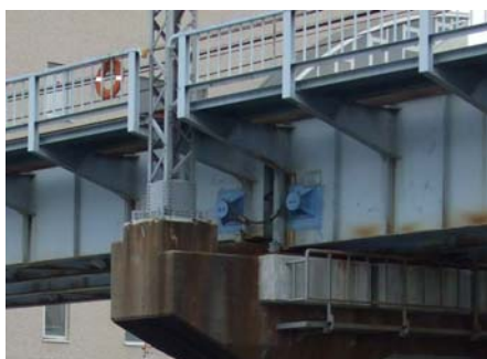
【桁連結及び桁受け部拡幅工法】
