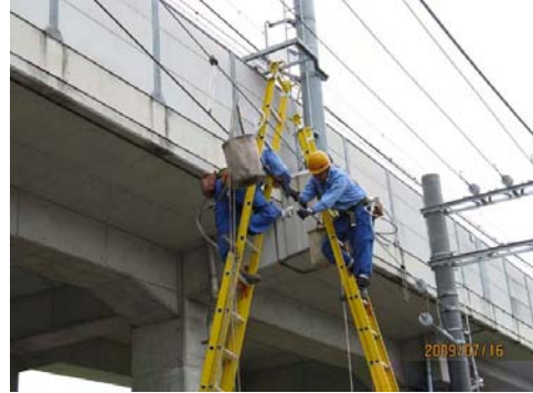
【電車線断線復旧訓練】
