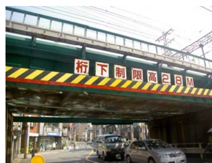
【橋桁防護工（桁）】
