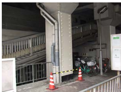
【一面せん断補強工法】
