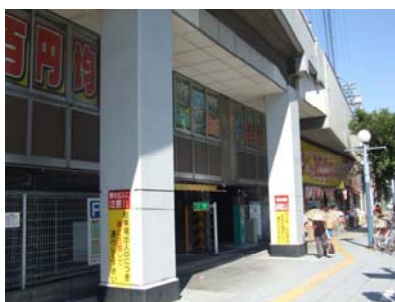
【鋼板巻き立て補強工法】
