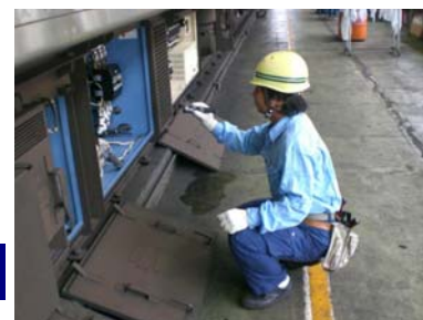
【状態・機能検査(月検査)】
