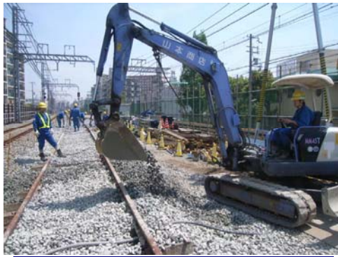
【仮線工事現場(神戸市内)】
