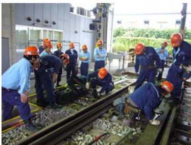
【信号設備障害復旧訓練】
