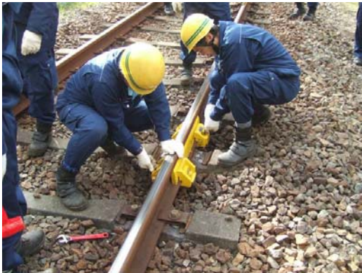
【レール折損事故応急復旧訓練】
