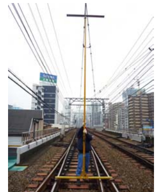
【交差装置点検】
