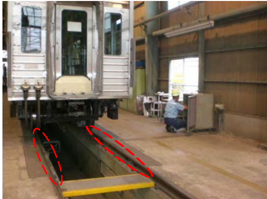
【破線内がひずみゲージ設置箇所】
