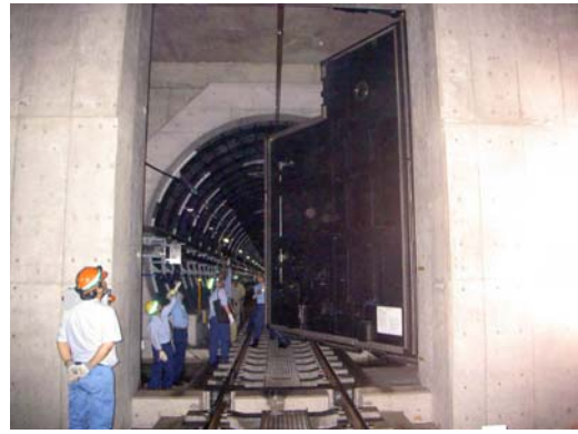
【阪神なんば線 トンネル内水防鉄扉開閉訓練】
