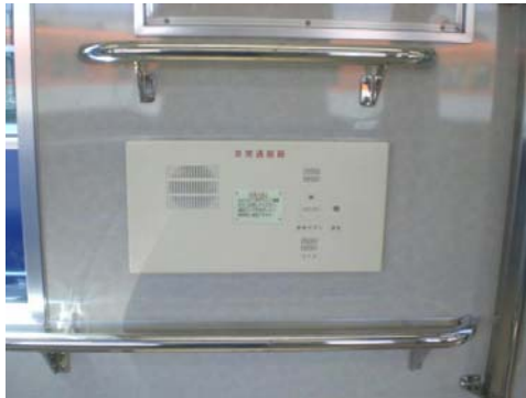
【非常通話装置(非常通報器)】
