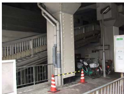
【一面せん断補強工法】
