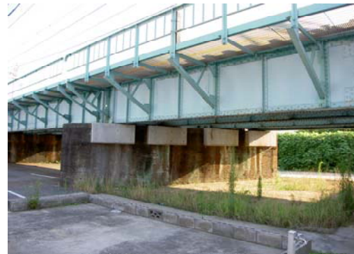
【桁受け部拡幅工法】
