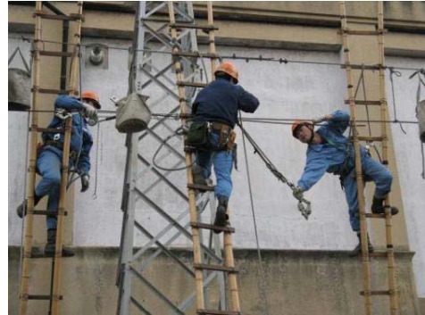
【電車線断線復旧訓練】
