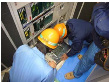
【信号設備障害復旧訓練】
