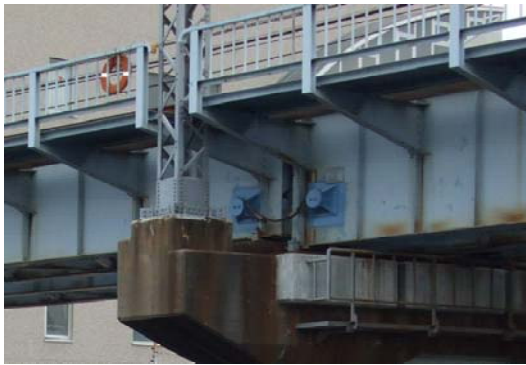
【桁連結及び桁受け部拡幅工法】
