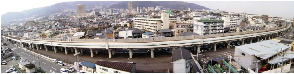
【本線住吉・芦屋間連続立体交差事業の内、完成した住吉・魚崎間高架】
