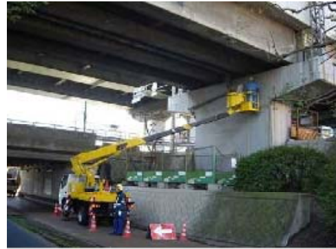
【近傍での詳細目視検査】
