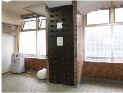
【一面せん断補強工法】
