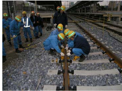
【レール折損事故応急復旧訓練】
