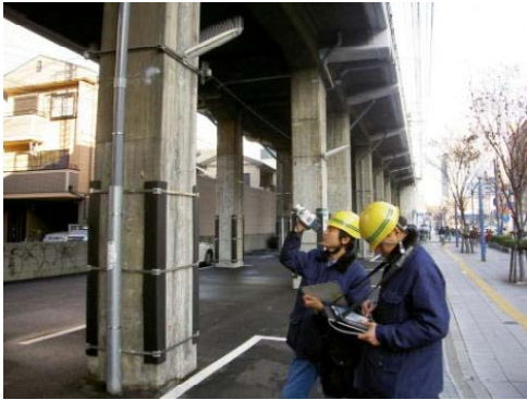
【高架下からの目視検査】
