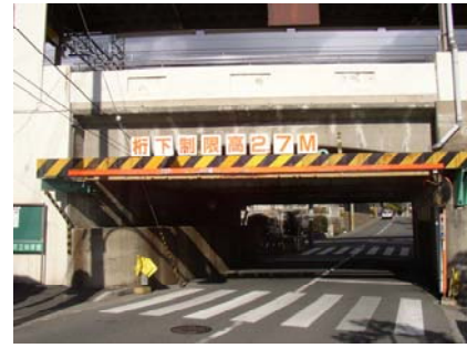
【橋桁防護工(桁)】
