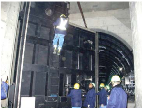
【トンネル内水防門扉開閉訓練】
