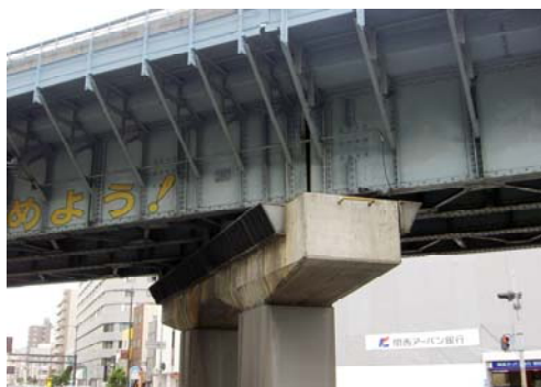
【桁受け部拡幅工法】
