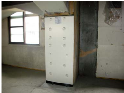
【一面せん断補強工法】
