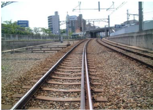
【脱線防止ガード 設置現場】
