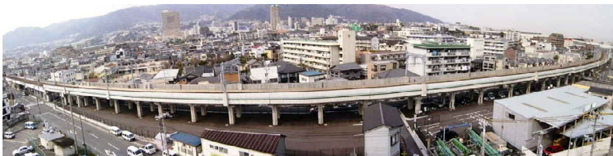
【本線住吉・芦屋間連続立体交差事業の内、完成した住吉・魚崎間高架】
