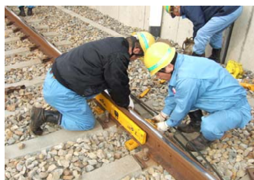
【レール折損事故応急復旧訓練】
