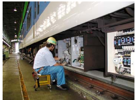
【状態・機能検査（月検査）】
