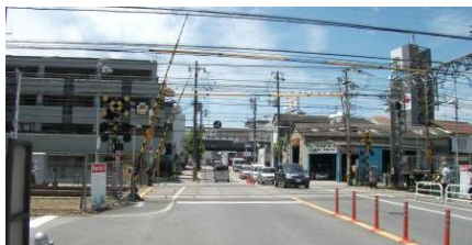
〈工事前の様子〉
