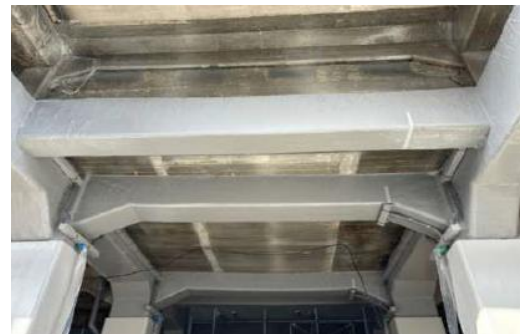
〈高架下補強後の様子〉
