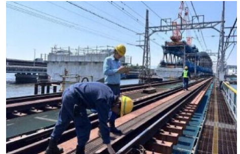
〈線路の状態確認の様子〉
