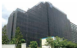
マンション大規模修繕
