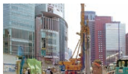
梅田3丁目障害撤去工事
