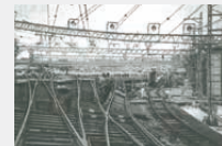
被災した石屋川車庫
