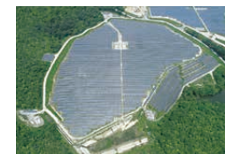
兵庫三田太陽光発電所
