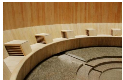
椅子のヒジ置き部分から冷風が取り込まれる。
