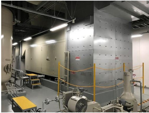
自家用発電機
