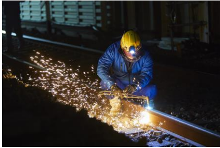
線路保守作業の様子
