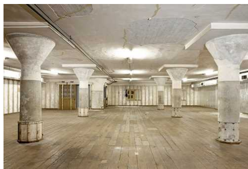
▲歴史的なマッシュルーム型柱を継承(写真は解体前)
