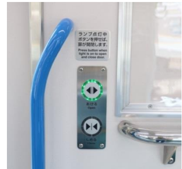
【ドア横の扉開閉ボタン】
