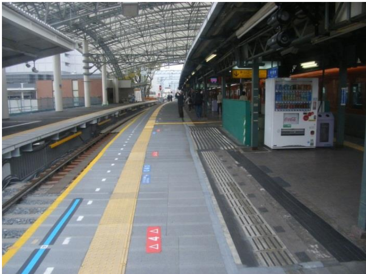
【 ホーム拡張（下りホーム） 】
