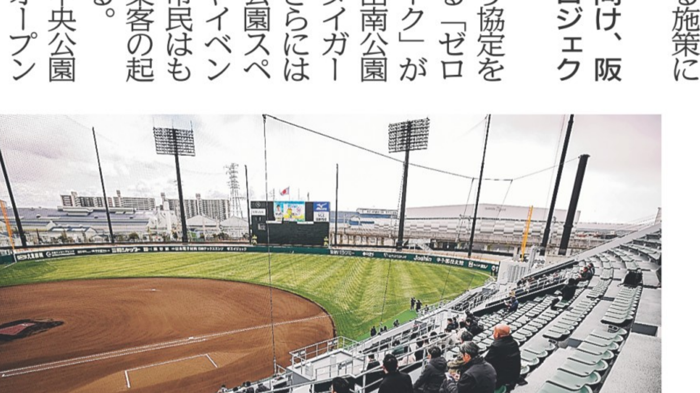
3月にオープンする阪神タイガース2軍球場「日鉄鋼板SGLスタジアム尼崎」ニ崎市杭瀬南新町3
