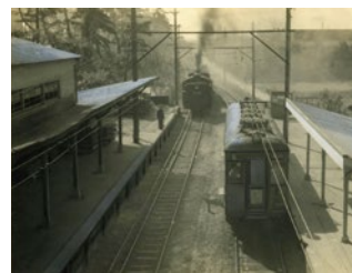
武庫川線武庫川停車場(三線軌条式)
