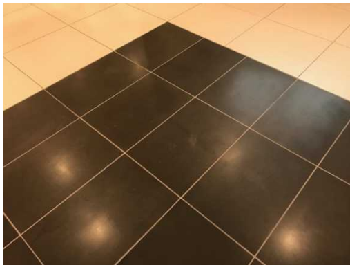
溶岩プレートを敷設した床暖房
