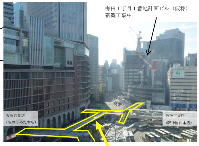
阪急阪神連絡デッキ 梅田新歩道橋 現場写真（2017年2月22日撮影）※北側から南東方向を望む
