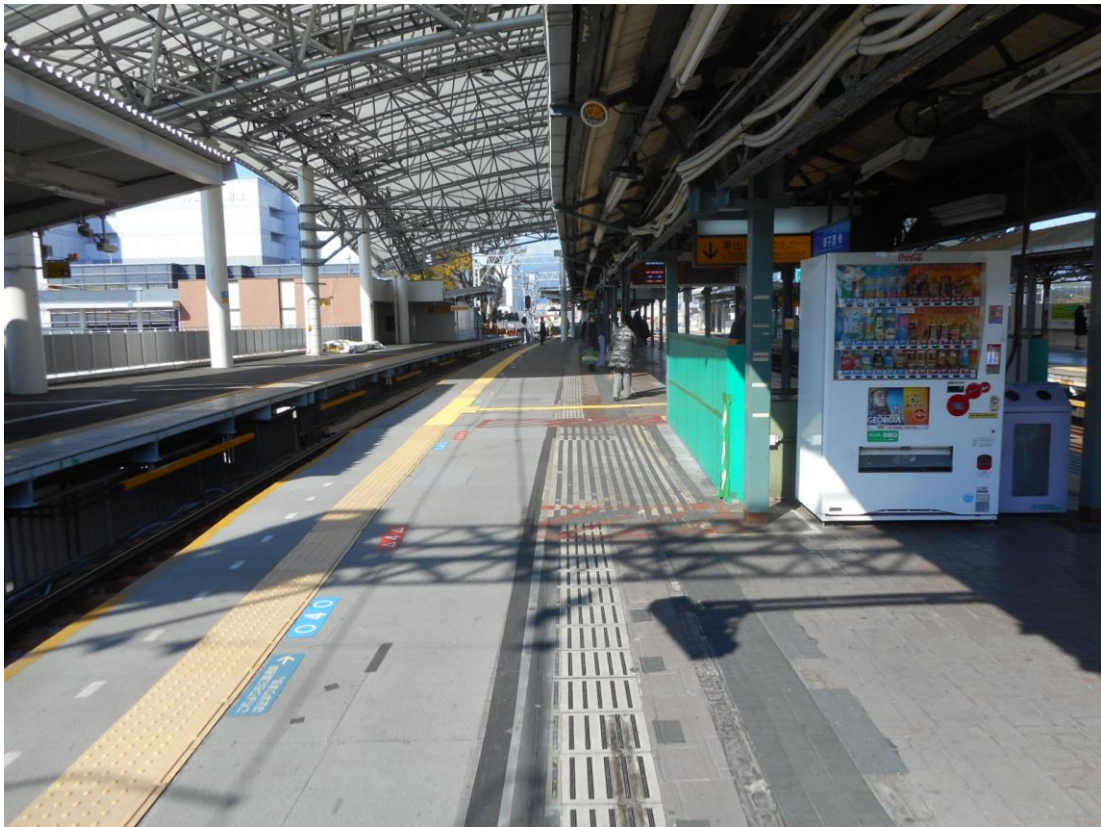
【 ホーム拡幅 （下り線ホーム） 】
