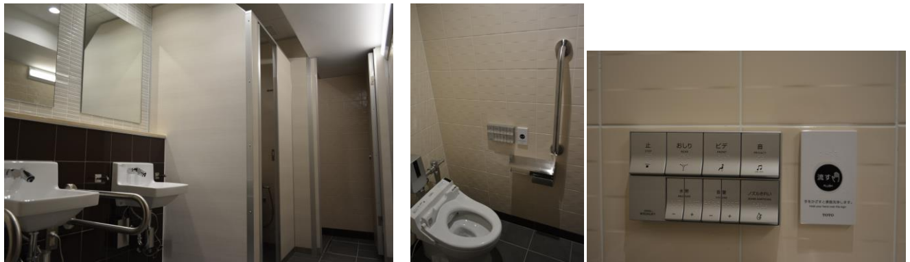
【改良工事が完成した大物駅トイレ】
