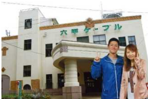
六甲ケーブル山上駅舎 (近代化産業遺産)
