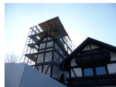
バリアフリー工事(エレベーター設置)
