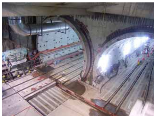
近鉄難波駅西方立坑部
