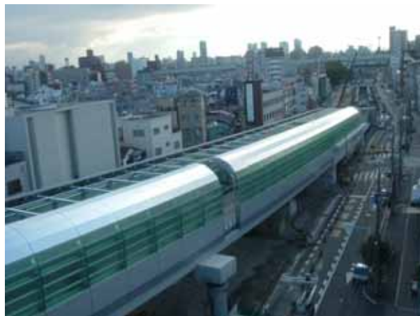
高架区間 (西九条 ~ 九条間)
