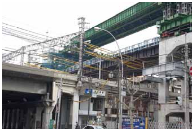
西九条駅 J R 上高架部分
